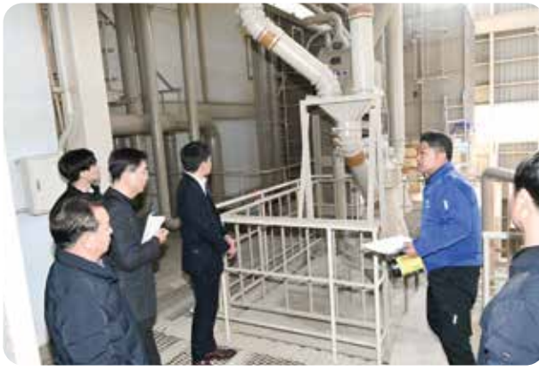
▲ライスセンターの設備をJA職員が説明
